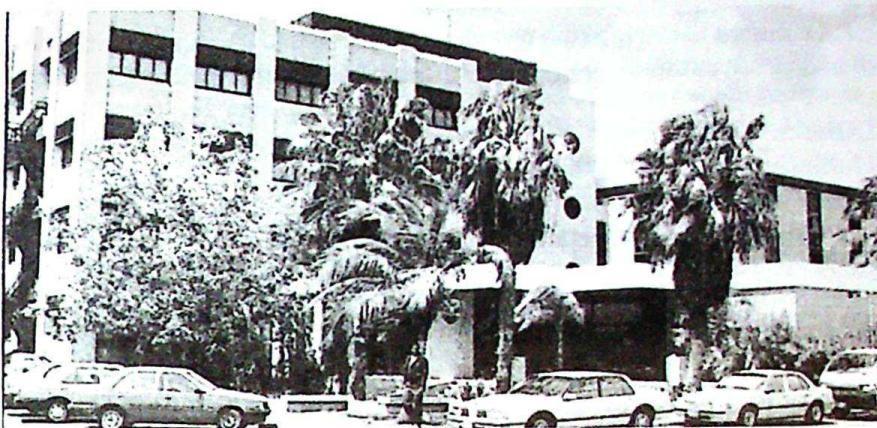
Vista di Edificio di Douane.
