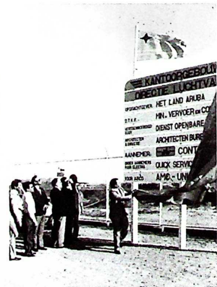
Ministro Benny Nisbet develando e borch, pa duna inicio na construccion di edificio pa Departamento di Aviacion Civil. (1994)
